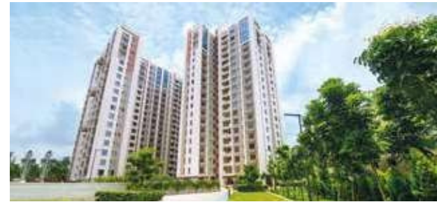
Ozone, South EM Bypass
